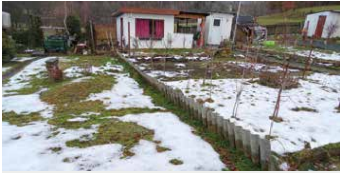
Hier wurden Wellasbestplattenstücke als Gartenbegrenzung verwendet. Durch das Eingraben und den Erdkontakt lösen sich Fasern und der Boden wird kontaminiert. Diese Platten müssen schnellstmöglich entfernt und sachgerecht entsorgt werden.
