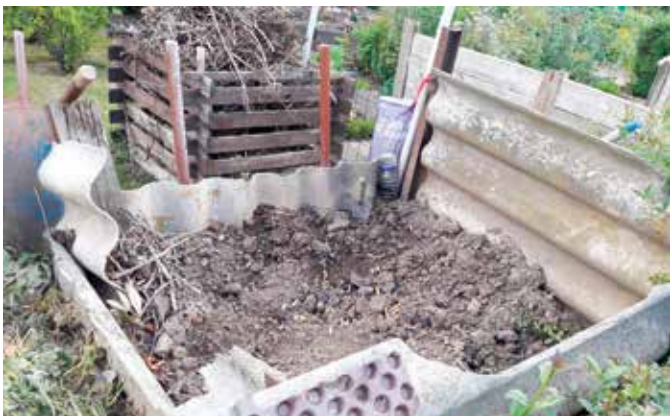
Oft werden in unseren Kleingärten zersägte und beschädigte Wellasbestplatten als Kompostbehälter zweckentfremdet benutzt. Hier müssen die Vereinsvorstände unbedingt eingreifen und die sofortige Beseitigung fordern.
